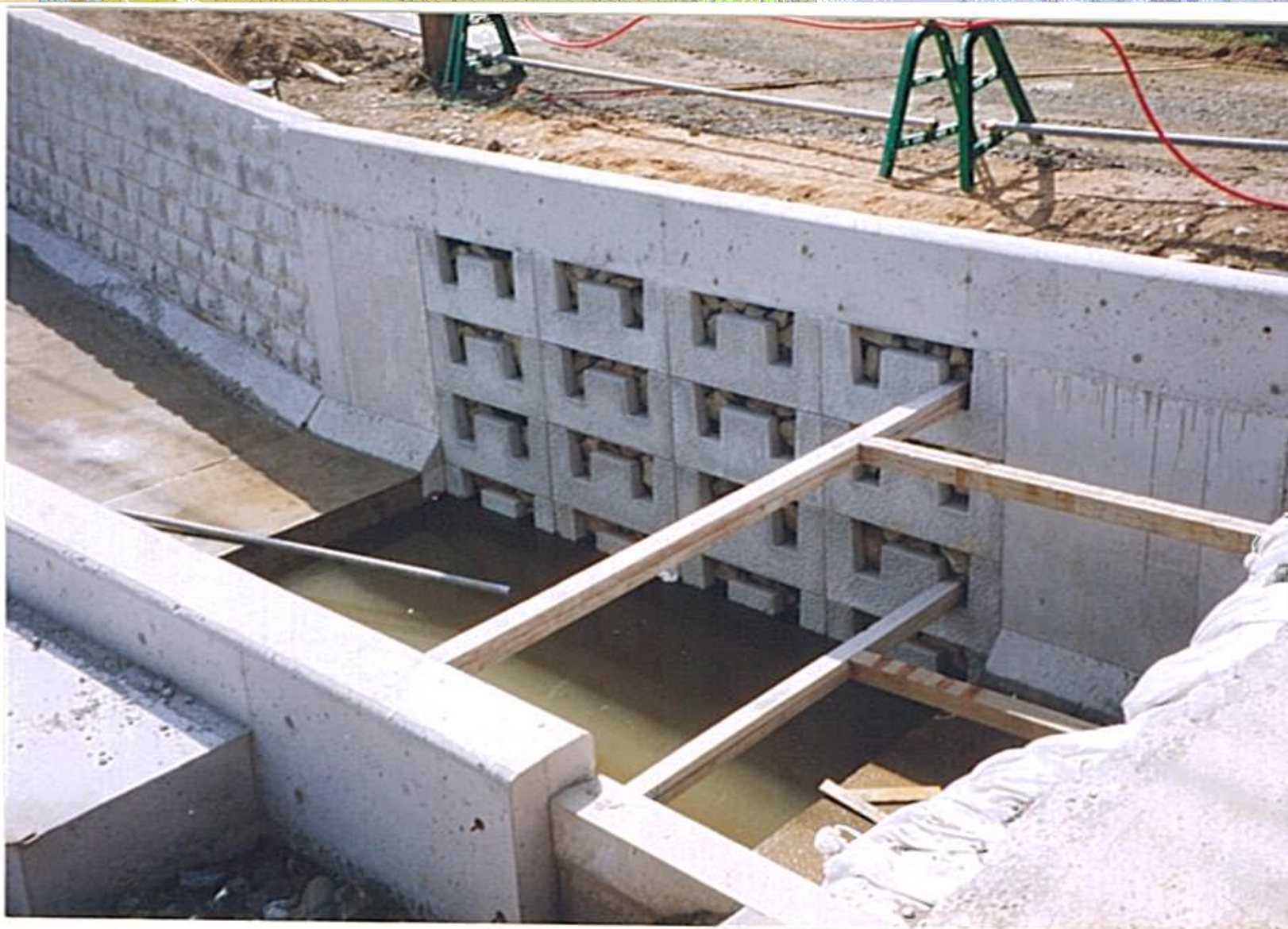
魚巢ブロック設置した水路
