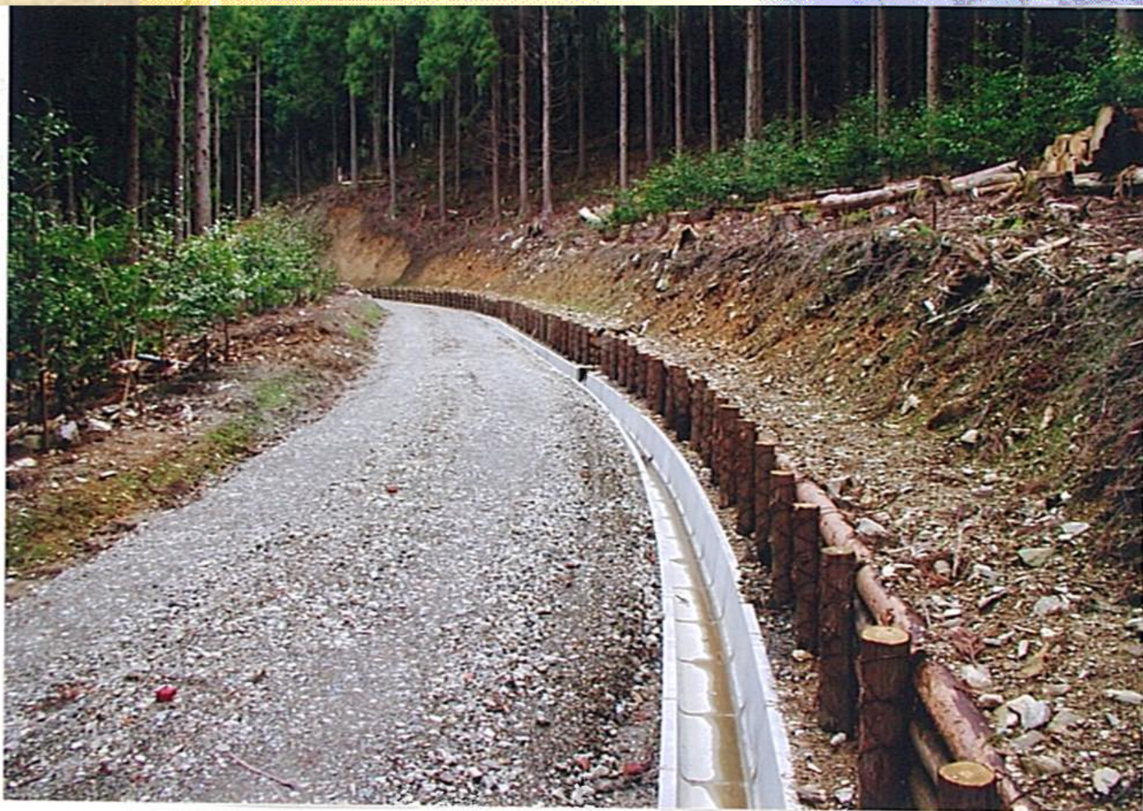
間伐材を利用したコンクリート構造物を最小根に止める
