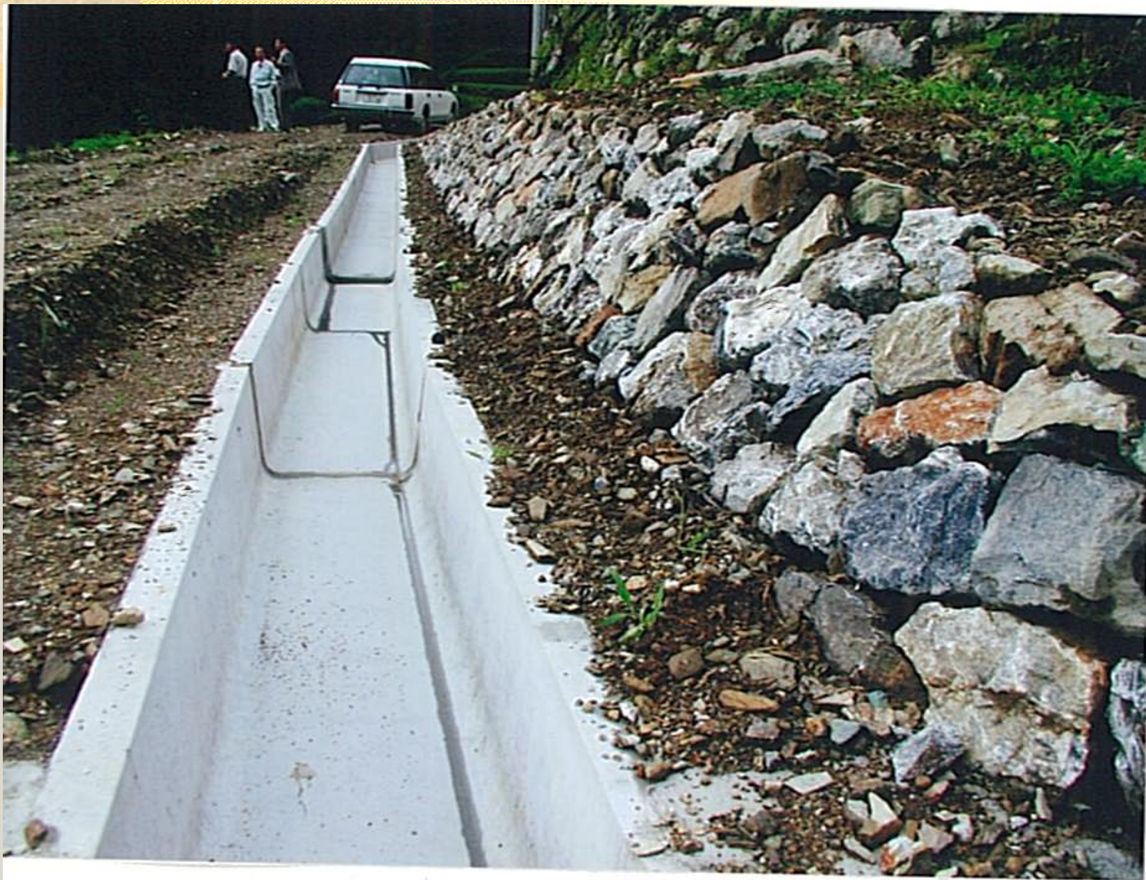
自然石を利用した法面の湧水処理
