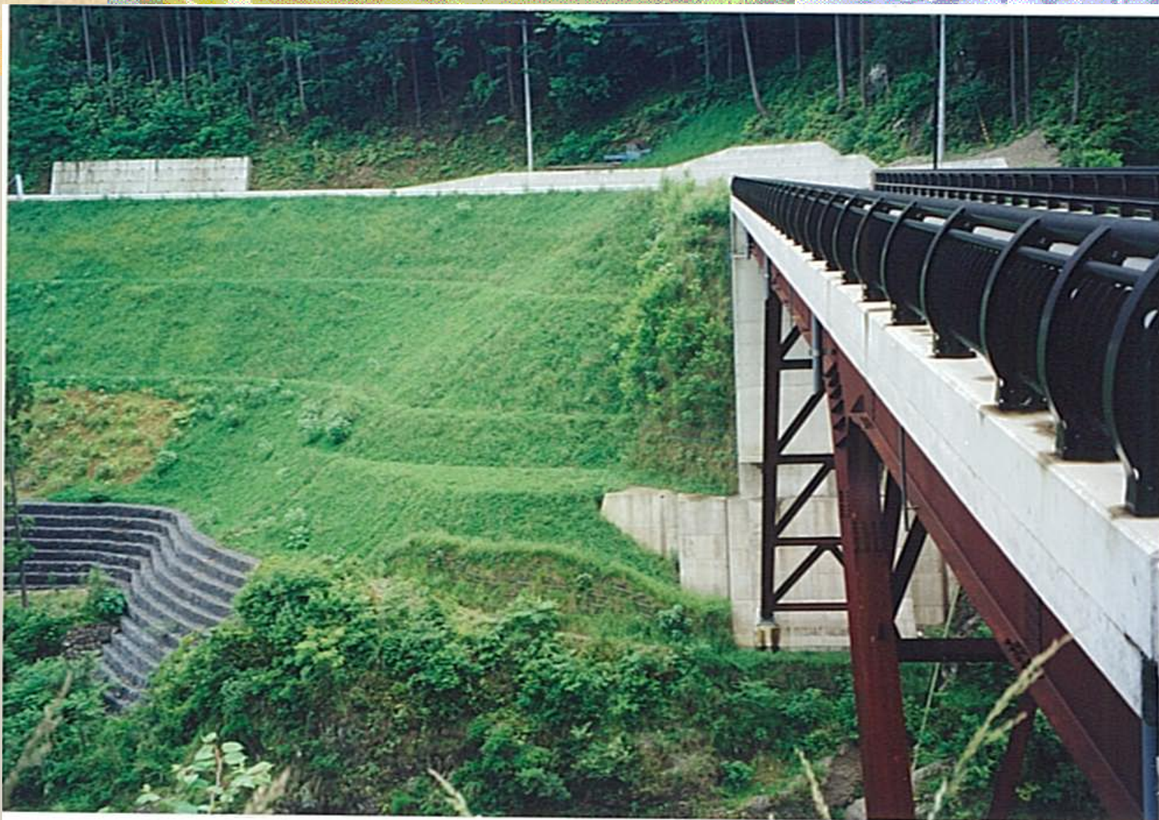
コンクリート構造物を最小根に止め法面緑化
