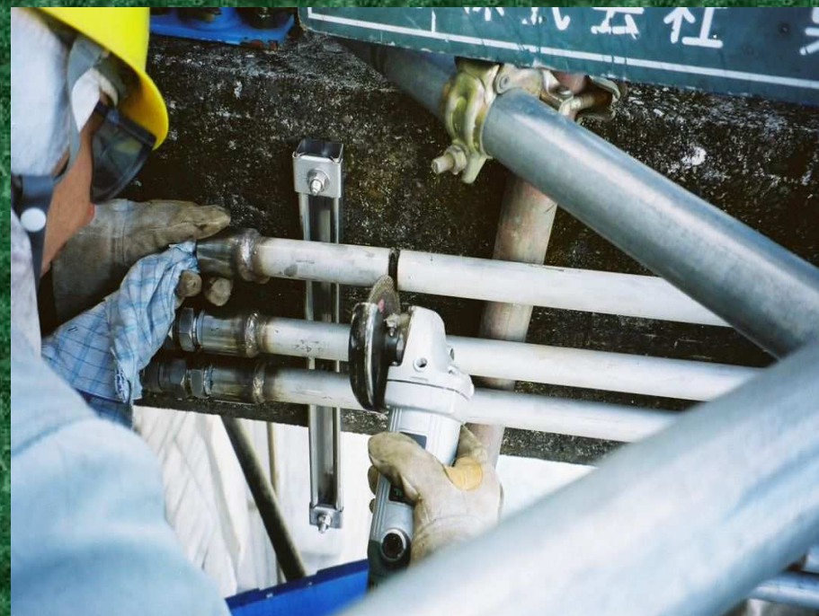
写5-3 配管の切断
