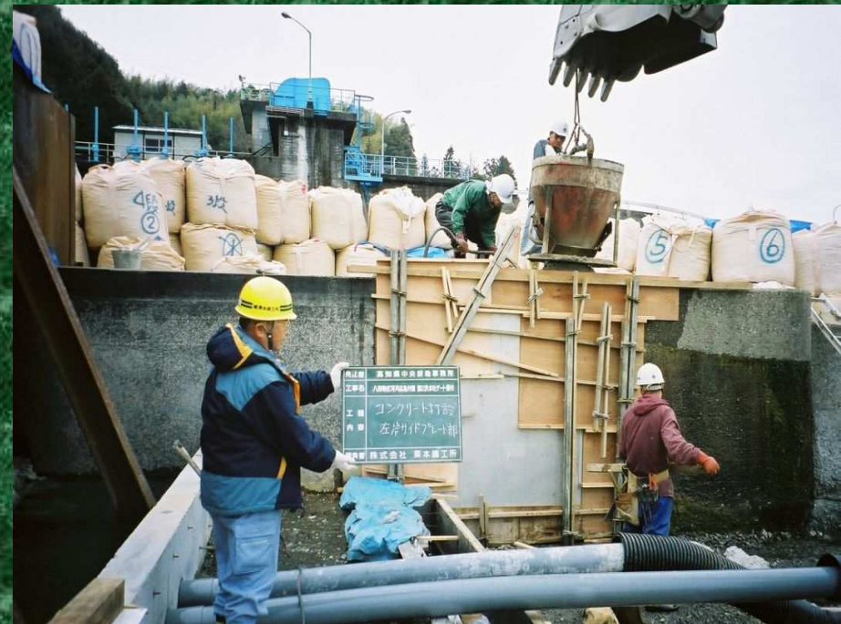
写6 二次コンクリート打設
